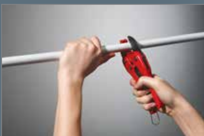
Отрезание трубы при помощи труборезных ножниц
